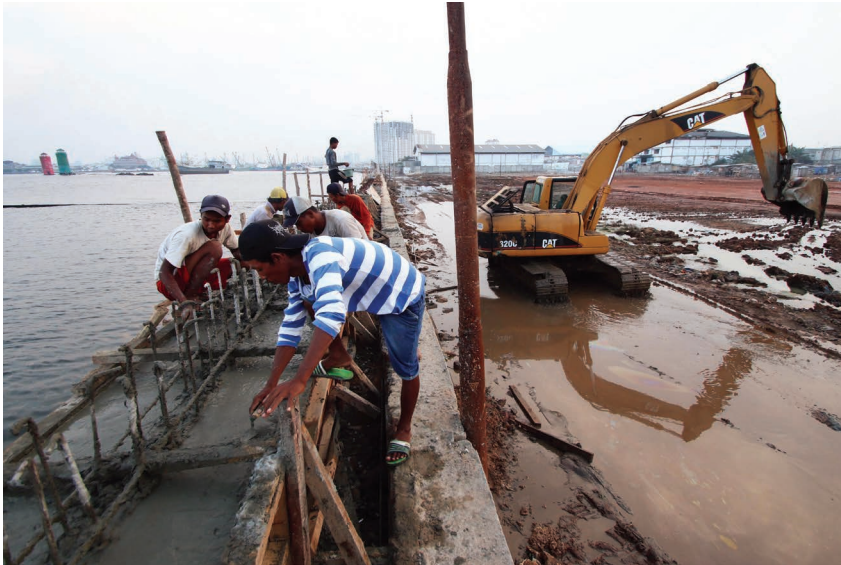
Pekerja menyelesaikan proyek pembangunan tanggul di Pantai Muara Baru, Jakarta, Rabu (2/12). Proyek pembangunan tanggul tersebut bertujuan untuk menahan banjir rob yang sering melanda kawasan Muara Baru. Pembangunannya dilakukan di garis bibir pantai sepanjang 32 kilometer.
